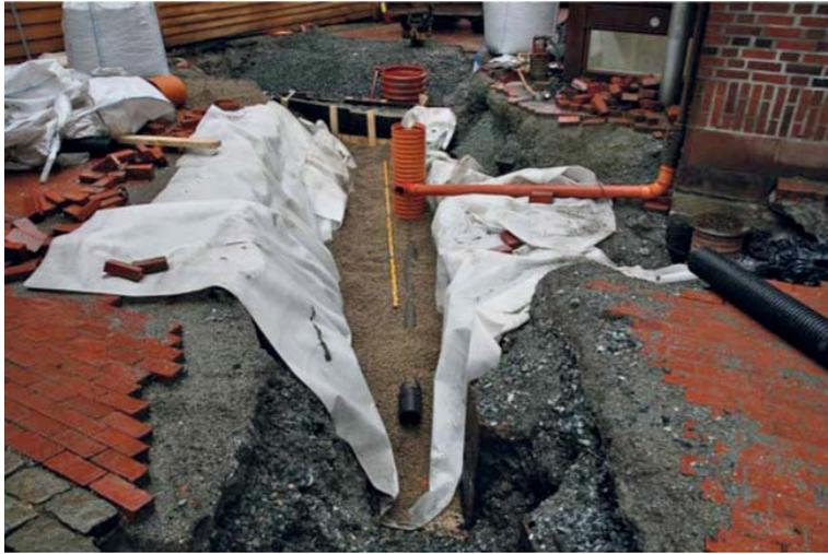
**FIGURE 4. CONSTRUCTION OF SUBSURFACE INFILTRATION SYSTEM**
